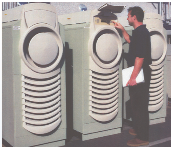
Три микротурбины мощностью 30-киловатт, работающие на свалочном газе в штате Калифорния, США.
